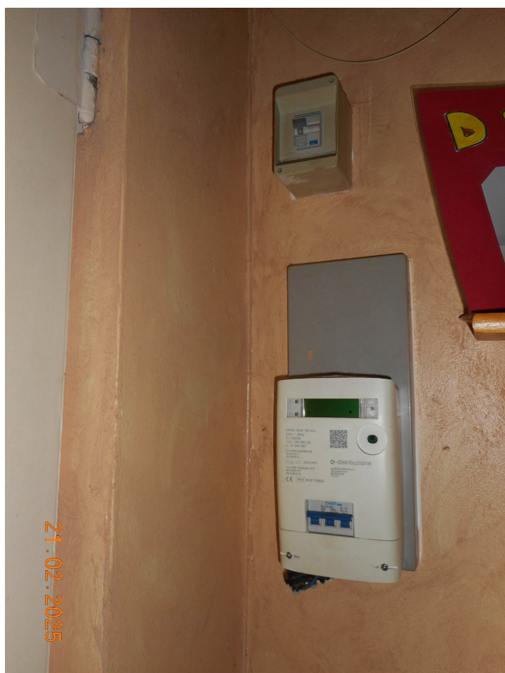
Contatore e differenziale elettrico
